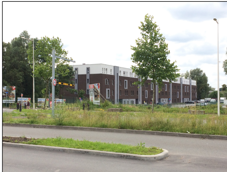
Figure 11 : Logements Thomas & Piron dans le PRU des Grands Prés (fin juin 2016)
