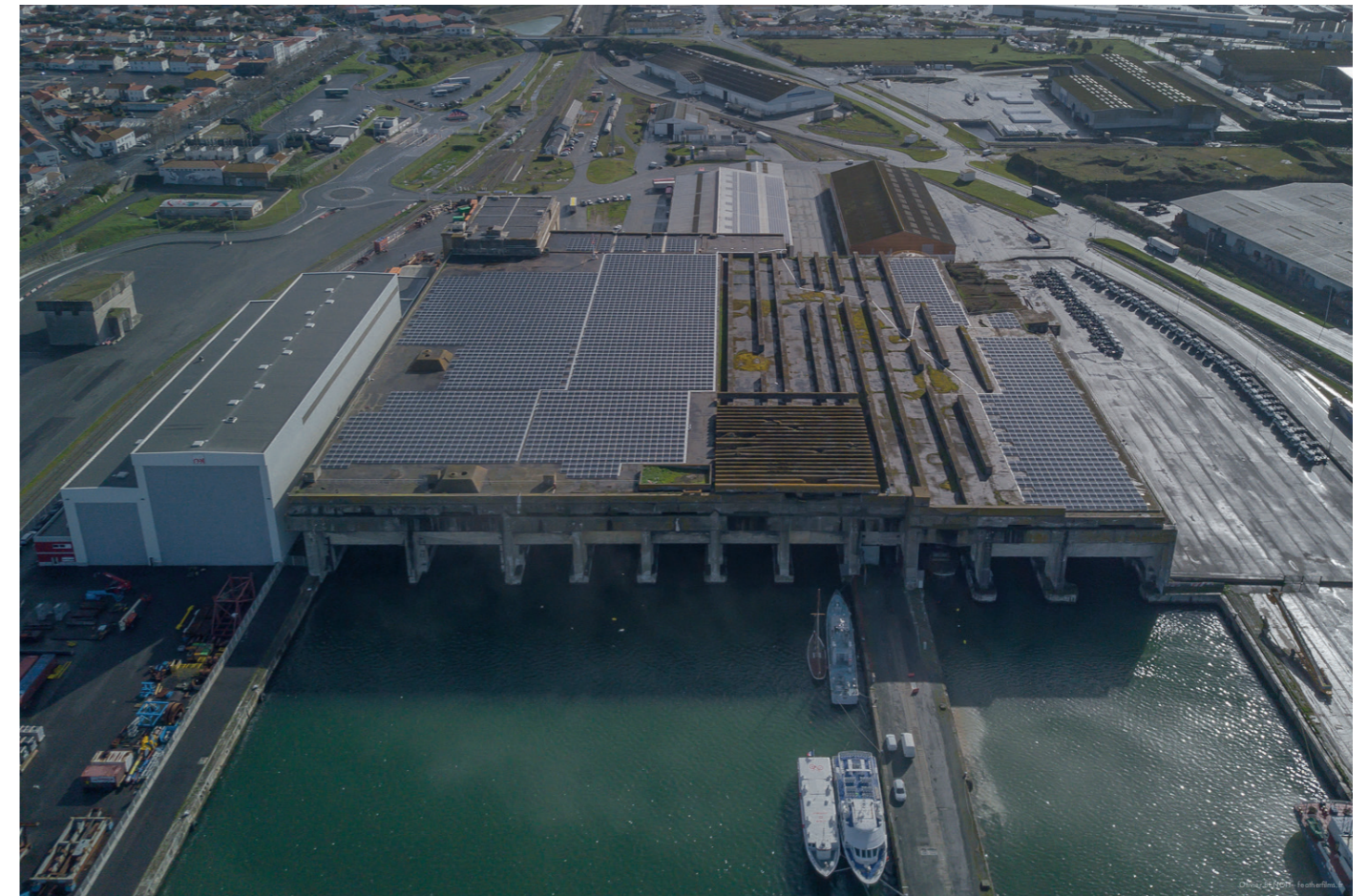
Figure 35 : Vue actuelle de la base de la Rochelle.
