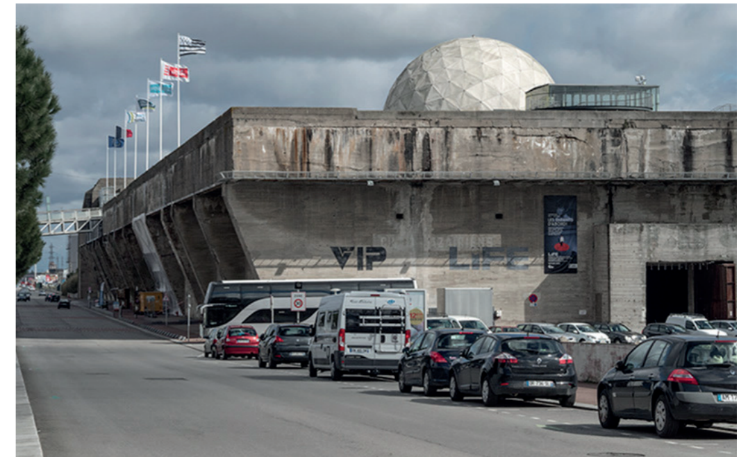
Figure 32 : Vue de la base de Saint-Nazaire en 2007.
