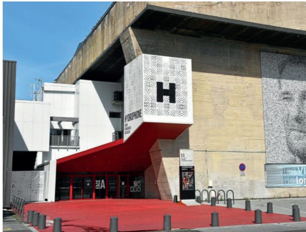
Figure 47 : Vue extérieure de l'Hydrophone.
