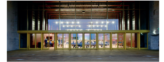
Figure 64 : Photos de l'Alvéole 12.
