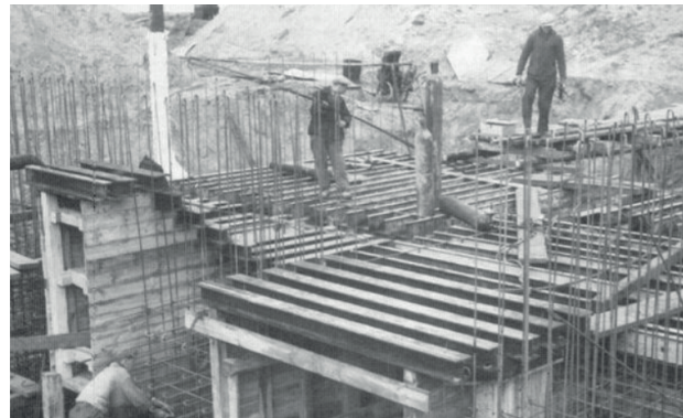
Figure 8 : Construction d'une fortification du Mur de l'Atlantique par l'organisation Todt.
