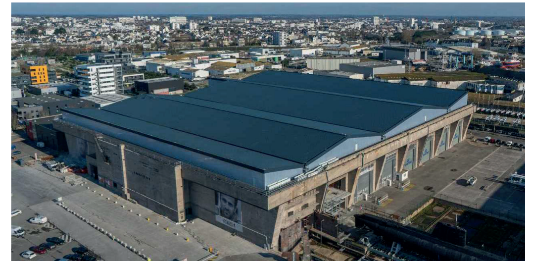
Figure 51 : Ferme solaire exploitée par l'entreprise Entech sur le toit du K2.
