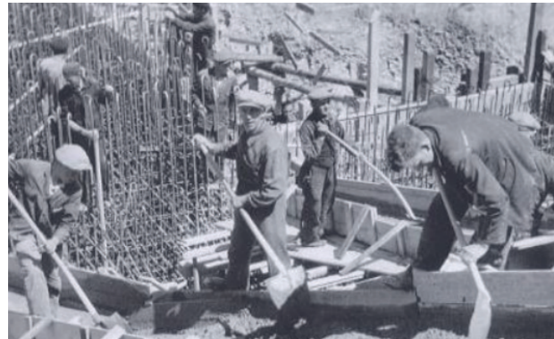
Figure 7 : Construction d'une fortification du Mur de l'Atlantique par l'organisation Todt.
