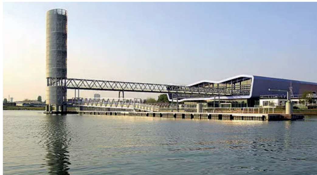
Figure 53 : Vue périphérique de la cité de la voile.
