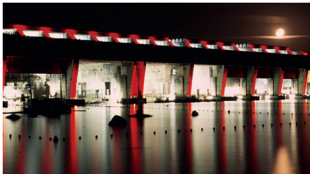
Figure 70 : Vue nocturne du dispositif d'éclairage mis en place par Jean Giacinto et Jean-Hughes Seurat en 2000.
