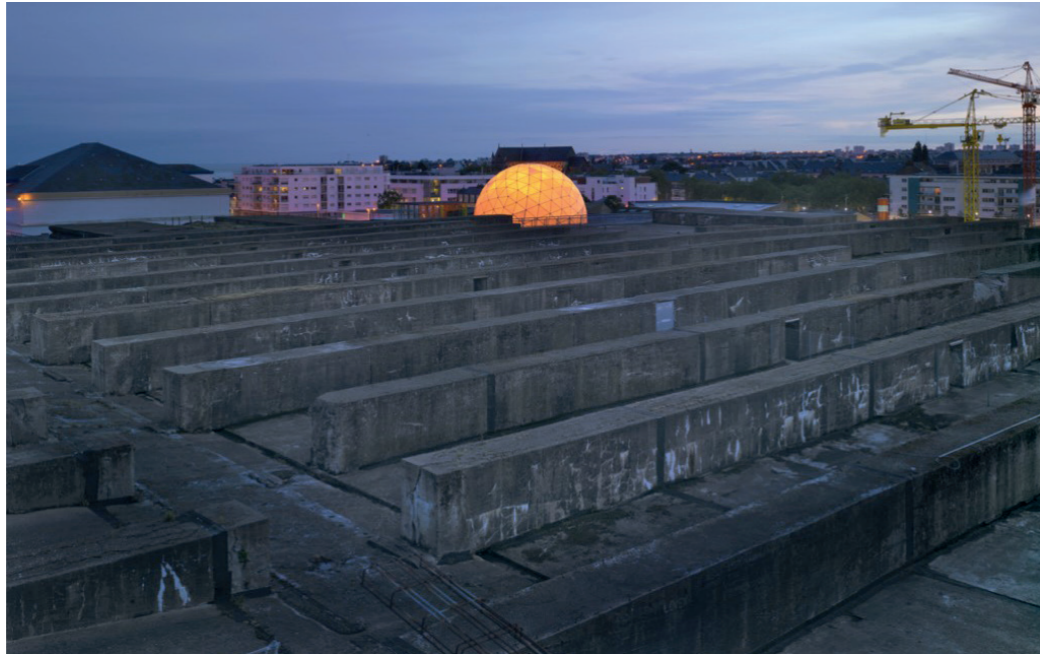
Figure 67 : Radôme du projet Alvéole 14 sur le toit de la base de Saint-Nazaire.
