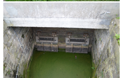
Figure 36 - De haut en bas, a. Masse arborée composant la coupure, b. Bras-mort atterri, c. Vannes de la station de pompage closes (Source : C. Dhellemmes, 2022)
