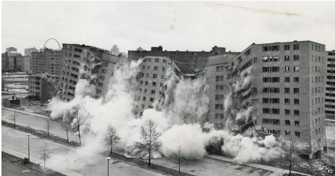
Figure 15 Démolition Pruitt-Igoe en 1972
