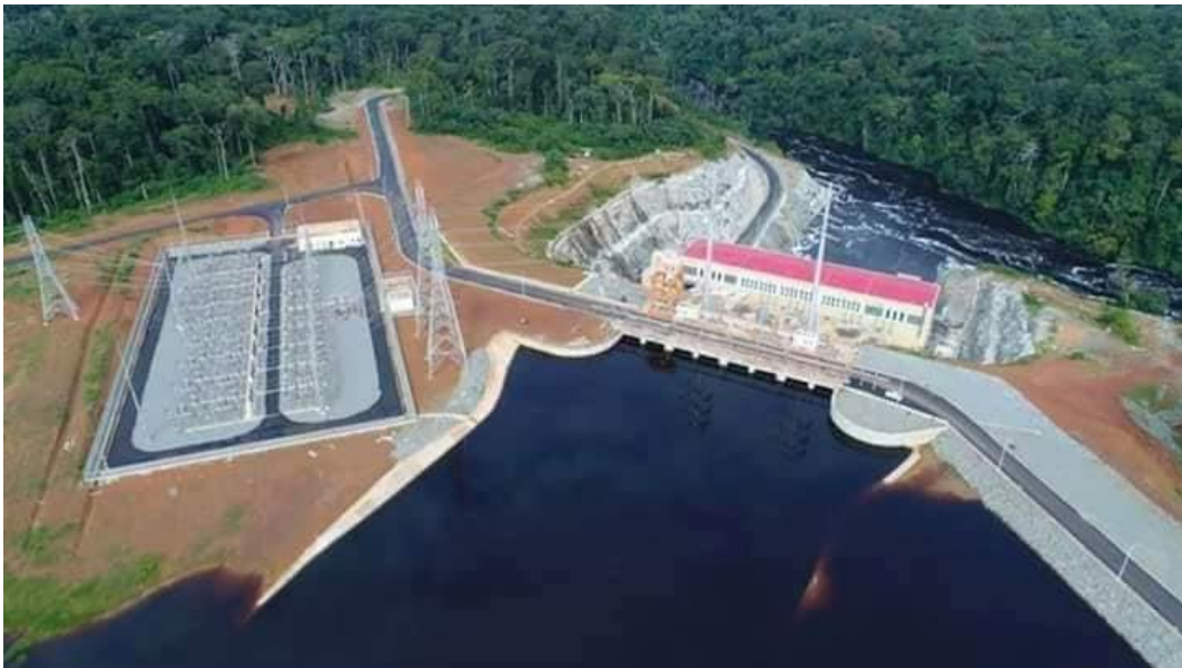
Figure 18. Barrage hydroélectrique Mékin
