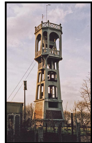
Figure II.1.4 : Puits n°4 surnommé la Belle-Fleur (Source : Derelicta)
