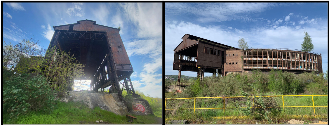
Figures II.2.25 et 26 : État existant de la Halle de la coulée et la Rotonde (Source : photos personnelles)
