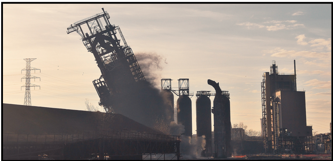
Figure II.2.1 : Dynamitage du haut-fourneau HF6 (Source : Gaudry Steph)
