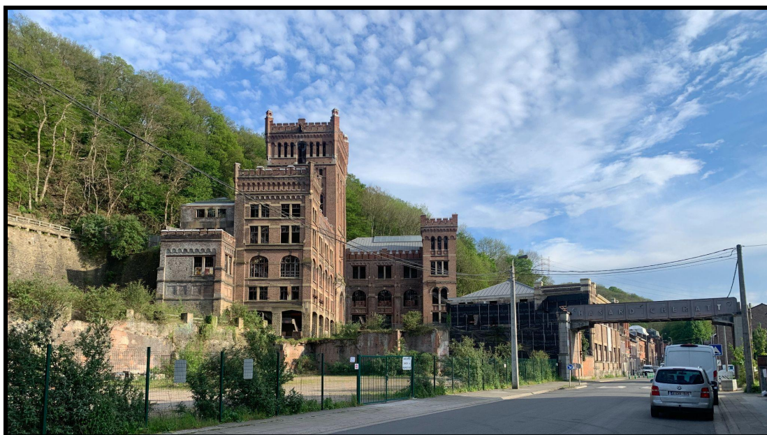
Figure : II.1.8 : La tour Malakoff et la passerelle (Source : photo personnelle)
