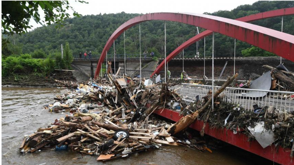
FIGURE 1.1 – Pont de la Rochette à Chaudfontaine (Image : https://www.lavenir.net/regions/2021/07/22/video-chaudfontaine-un-pont-a-bouge-pousse-par-les-dechets/-de-la-vesdre-Z7ISXPR6F5BSBHZ5CI005XUY4/ )
