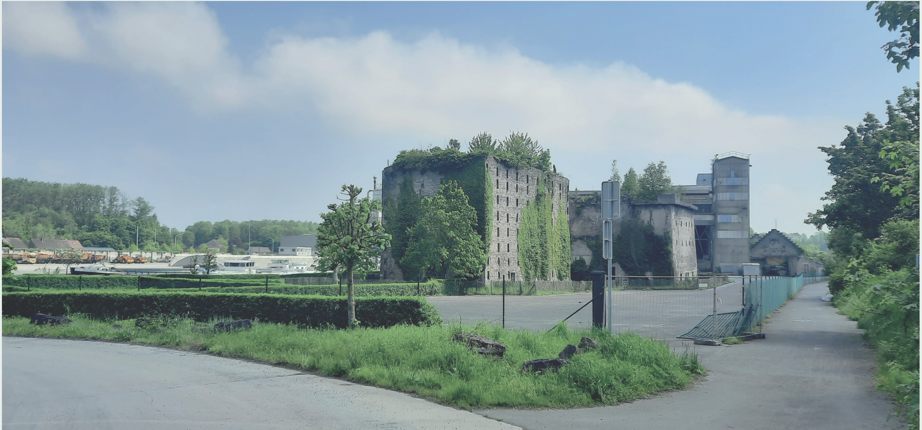
Photographie des Fours Thorn, abords des halages de l'Escaut, C. Merckx, avril 2023
