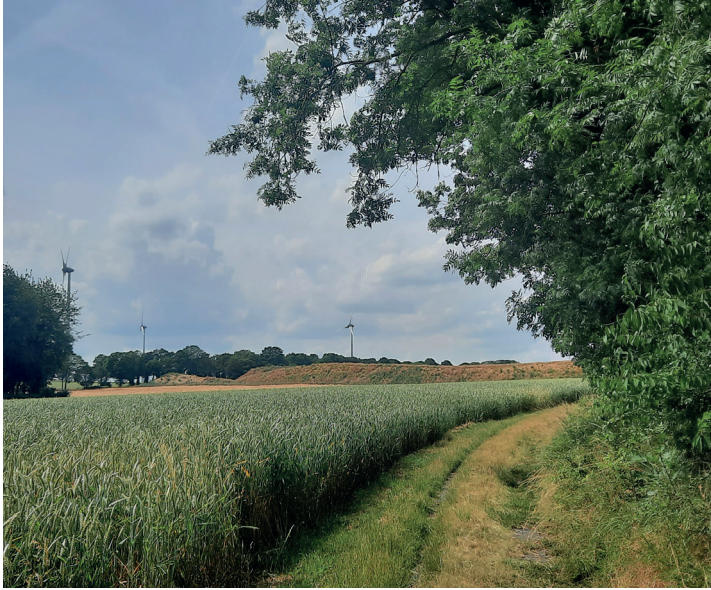
Photo n°5, vue sur les merlons en voie d'installation du site n°20
