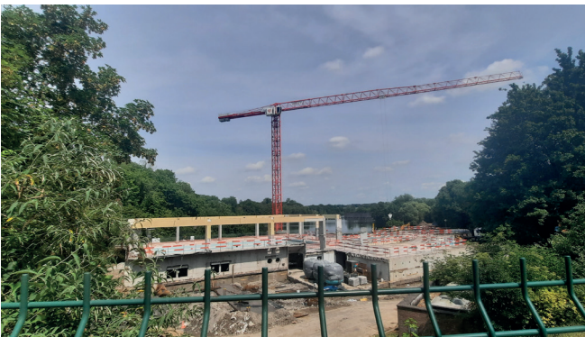
Photo n°19, Zone de baignade de la Carrière de l'Orient en chantier
