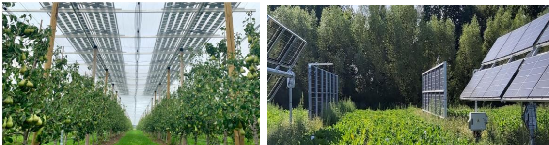
Figure 4 : Projet expérimentale de panneaux solaires à modules de feuilles transparentes et des cellules classiques de silicium au-dessus d'un verger de poiriers à Bierbeek, Belgique (à gauche), et de système bifacial vertical et tracker à axe unique sur le site de Grimbergen
