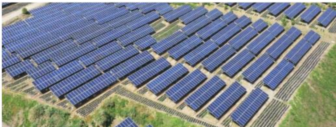
Figure 7 : Installation d'un projet agrivoltaïque de 200 mégawatts (MW), situé sur des terres dégradées associés avec la culture d'espèces tolérantes à l'ombre (bletilla, le paeonia, le framboisier, etc.) à Jiangshan, en chine (Xiao et al., 2022)
