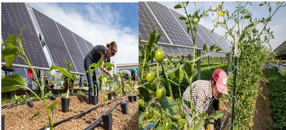
Figure 9 : Centrale au sol avec panneaux bifaciaux sur cultures de plantes à gauche et panneaux monofaciaux à droite sur cultures de Tomates au Colorado (US) https://www.nrel.gov/solar/market-research-analysis/agrivoltaics.html
