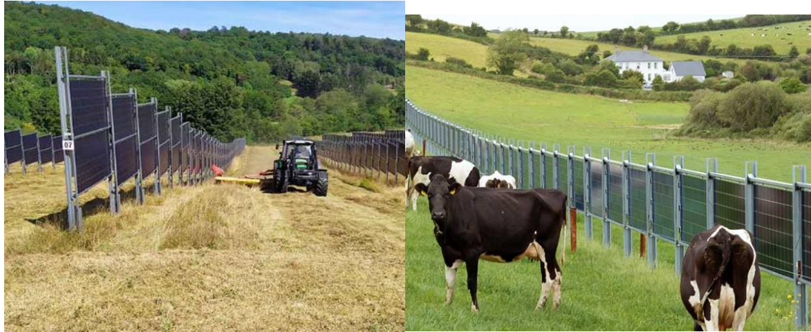
Figure 3 : Centrale au sol avec des modules bifaciaux montés à la verticale associée à la pâture d'une prairie sur le site de Donaueschingen (à gauche), et servant de clôture pour des vaches (à droite)
