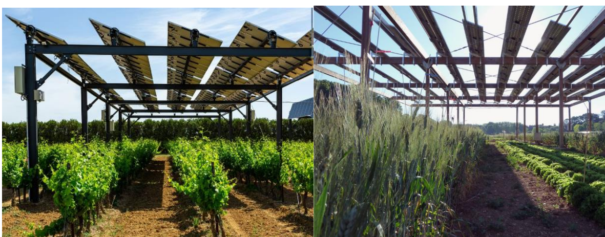
Figure 2 : Ombrières mobiles surélevées sur culture de vigne (à gauche) et sur culture de blé et laitue (à droite) en France ( https://sunagri.fr/resultats-viticulture/ et (Marrou, 2019))
