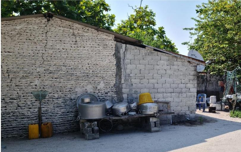
Figure 21 : Photographie d'une habitation typique sur l'île de Kendhikulhudhoo. Celle-ci est construite à gauche à partir de blocs de récifs, et à droite à partir de blocs en béton.
