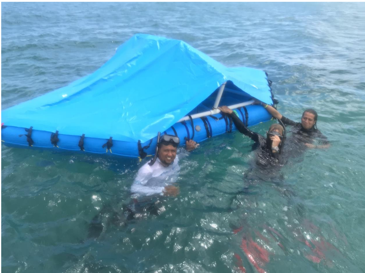
Installation d'une CRIB en mer
