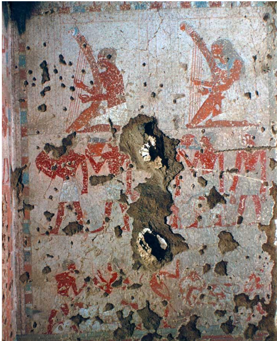
Figure 33 - Mur est, côté nord chapelle, TT 60 (©OSIRISNET)
