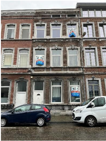
Figure 283 : Photo prise en 2023 d'une construction située rue d'Harscamp mise en vente. ©Photo personnelle
