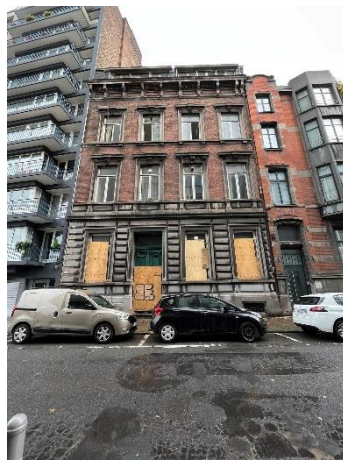
Figure 284 : Photo prise en 2023 d'une construction située quai Churchill, abandonnée. ©Photo personnelle
