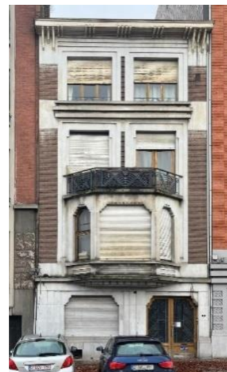
Figure 286 : Photo prise en 2023 d'un appartement situé quai du Condroz. ©Photo personnelle
