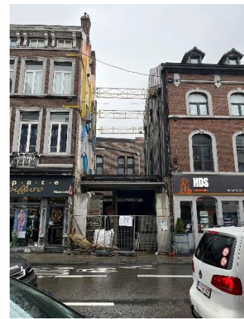
Figure 285 : Photo prise en 2023 d'une construction située rue Grétry, détruite. ©Photo personnelle
