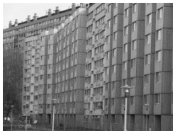
L'immeuble à Bondy
