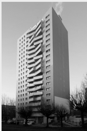
Fig. 101 - Immeuble avec ajouts de balcons
