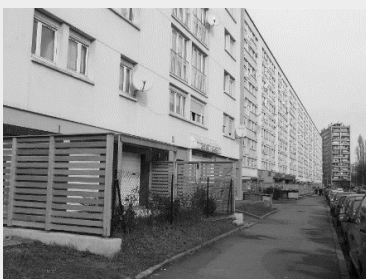
Fig. 84 - Immeuble avant la rénovation
