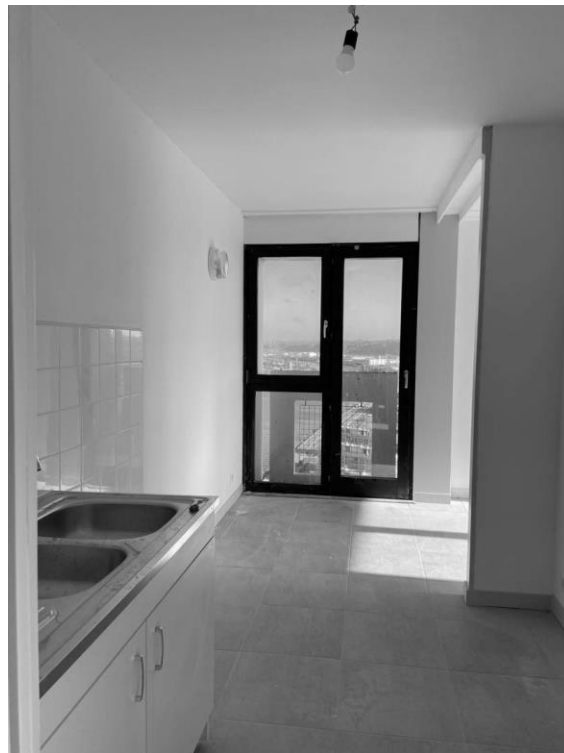
Fig. 53 - Cuisine après les travaux de rafraichissement Source : Photo prise par l'autrice
