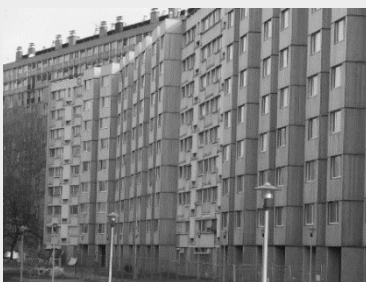
Fig. 83 - Immeuble garni de de boîtes multifonctionnelles
