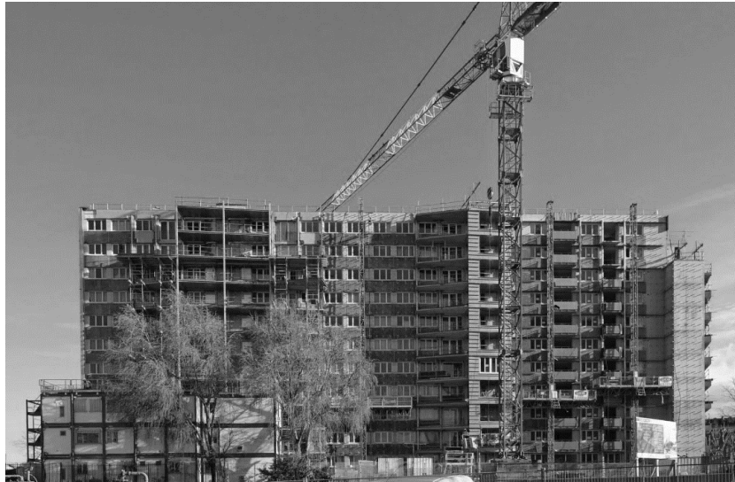
Fig. 72 - Chantier de la rénovation
