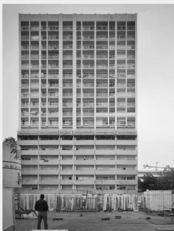
Fig. 111 - Immeuble avant la rénovation énergétique
