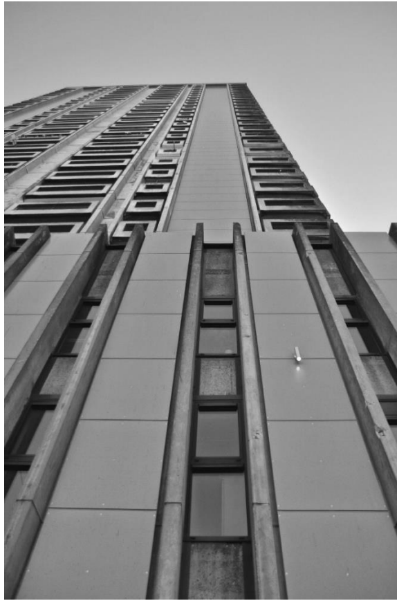
Fig. 33- La facade de la tour Match Source : Biemar&Biemar
