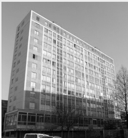
Fig. 95 - Immeuble avant la rénovation
