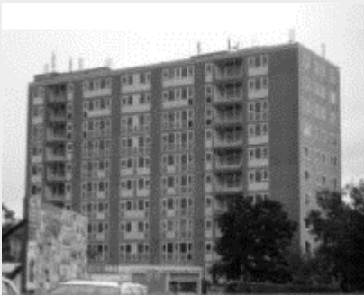
Fig. 89 - Immeuble avant les travaux de rénovation
