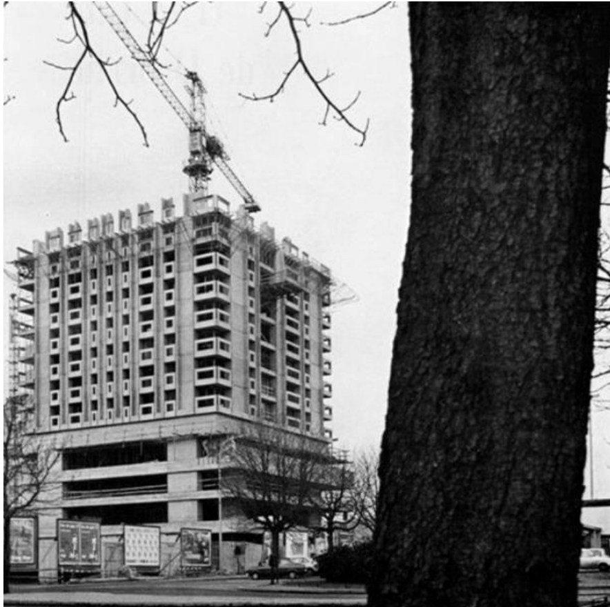
Fig. 31 - Construction de la tour Match
