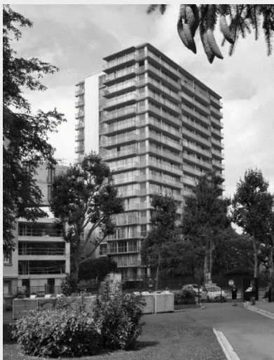
Fig. 106 - Extensions ajoutées après la rénovation Source : Druot F., Lacaton A., Vassal J-P., Transformation de la tour le Prêtre, Paris 17
