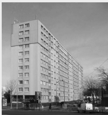
Fig. 70 - Immeuble avant les travaux de rénovation
