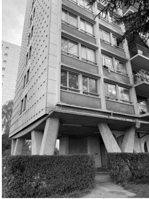
Fig. 28 - Pied d'un immeuble à Droixhe Source : Photo prise par l'autrice
