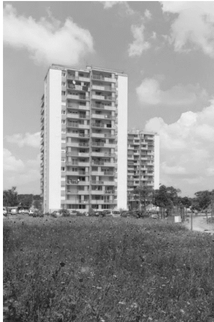
Fig. 79 - Les tours La Rabaterie Source : Groupe Arcane Architectes
