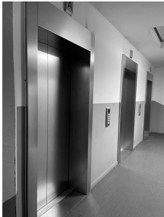
Fig. 57 - Ascenseurs Source : Photo prise par l'autrice
