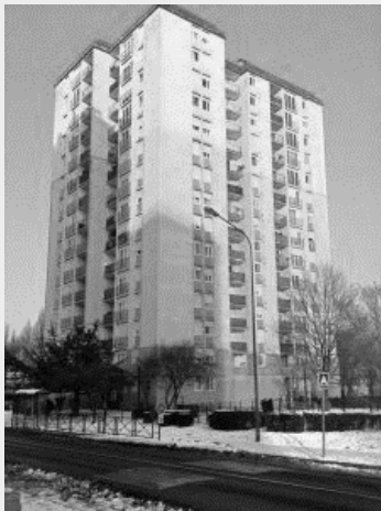
Fig. 76 - Immeuble avant les travaux de rénovation
