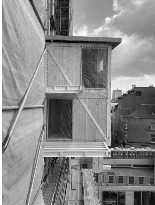
Fig. 98 - Assemblage extension-bâtiment existant Source : Wallonie-Bruxelles Architectures
