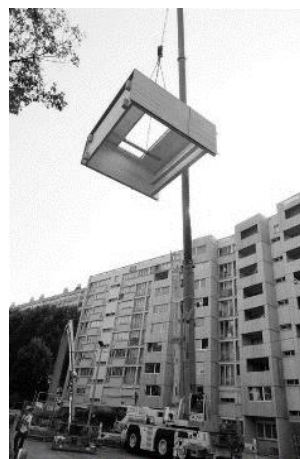
Fig. 87 - Grue avec module préfabriqué
