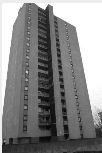
Fig. 100 - Immeuble avant les travaux de rénovation
