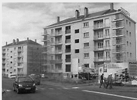
Fig. 116 - Immeuble avant les travaux pour l'installation d'extensions Source : Ouest France
