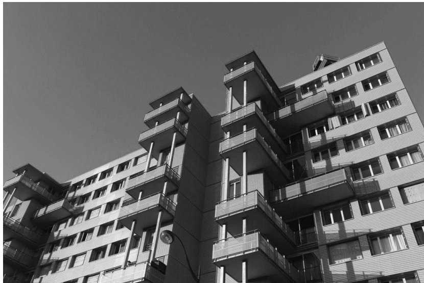
Fig. 73 - L'extension de la cuisine et l'ajout des terrasses
