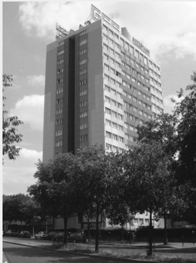
Fig. 105 - Tour avant les travaux de rénovation Source : Druot F., Lacaton A., Vassal J-P., Transformation de la tour le Prêtre, Paris 17
