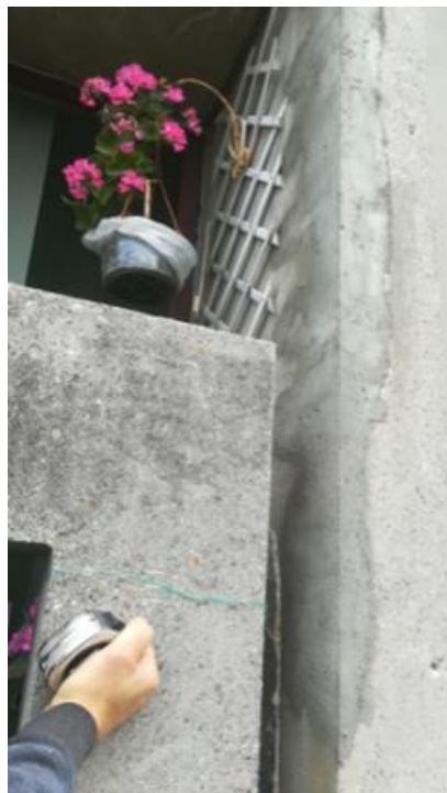
Fig. 12 - Réparation des dégradations Source : Cyrille Michel
