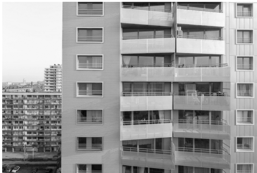
Fig. 103 - Les extensions de la tour Peterbos Source : P&P Architectes
