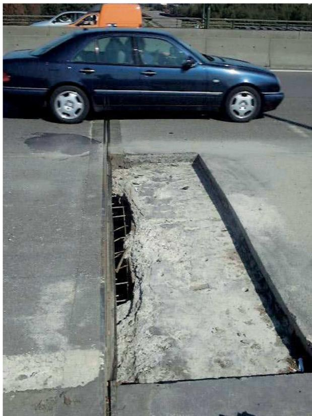
Figure 1: Dégradation du pont de Bastogne (Demars Ph., 2001)
