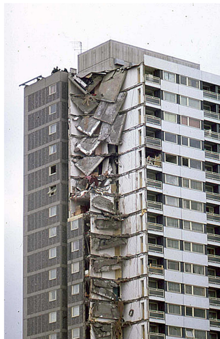
Figure 1 : Effondrement du Ronan Point 6
