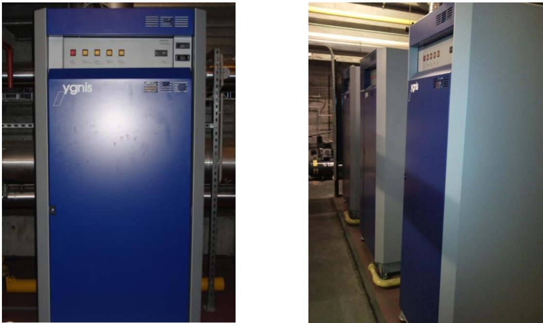
Figure 8 : Chaudières classiques de 318 kW (Aparecida Silva et al. , 2008)
