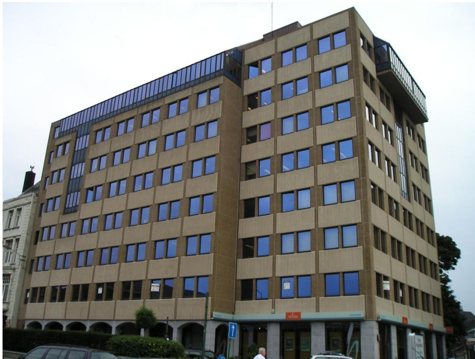
Figure 4 : Bâtiment à auditer à Charleroi
