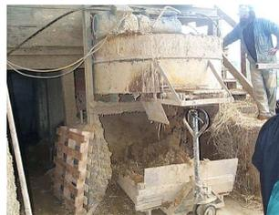
Figure 114 : Préparation de la bauge 3 (source : <http://www.bretagne-racines.ac-rennes.fr>)
