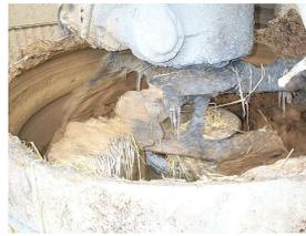
Figure 113 : Préparation de la bauge 2 (source : <http://www.bretagne-racines.ac-rennes.fr>)
