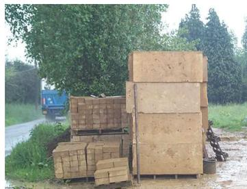
Figure 116 : Préparation de la bauge 5 (source : <http://www.bretagne-racines.ac-rennes.fr>)
