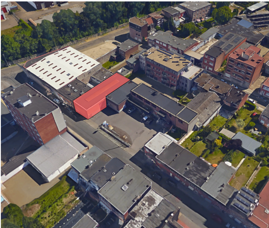
Figure 19 : Vue aérienne du cas d'étude n°3
