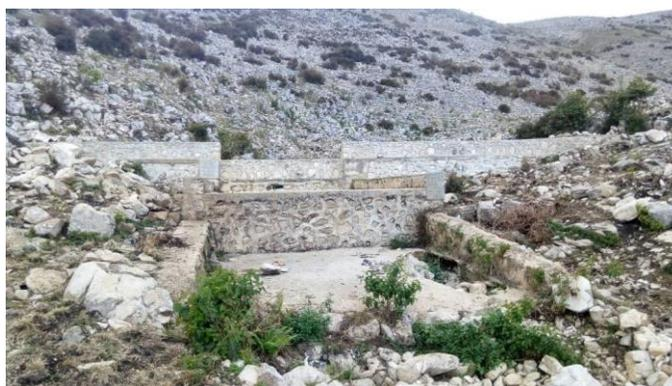
*Figure 9: Seuil en maçonnerie dégradé à Guayavier, commune de Saint Marc*
