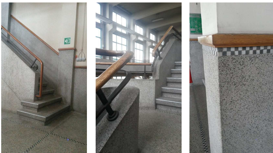
Fig.150 : Vues ascensionnelles de l'escalier en granito
