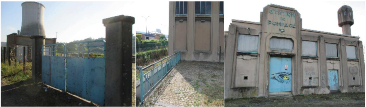
Fig.55 : Vues des ferronneries de la façade Nord
