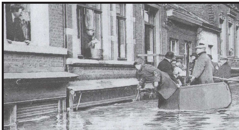
Fig.07 : Rez-de-chaussée sous eaux à Seraing
