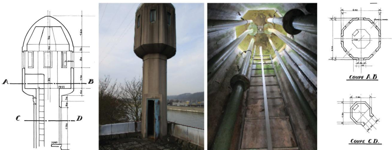
Fig.50 : Vues, plans et coupe de la tourelle d'amorçage
