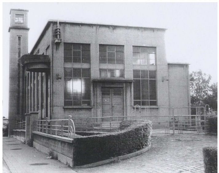
Fig. 148 : Vue ancienne de la façade Nord
