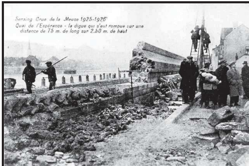
Fig.05 : Rupture de la digue dans le bas de Seraing
