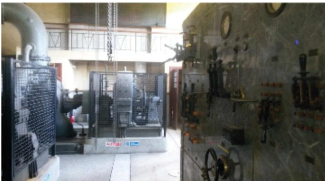
Fig.57 : Vue des tableaux de commandes
