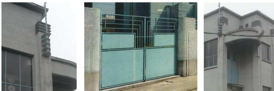
Fig.119 : Détails des ferronneries
