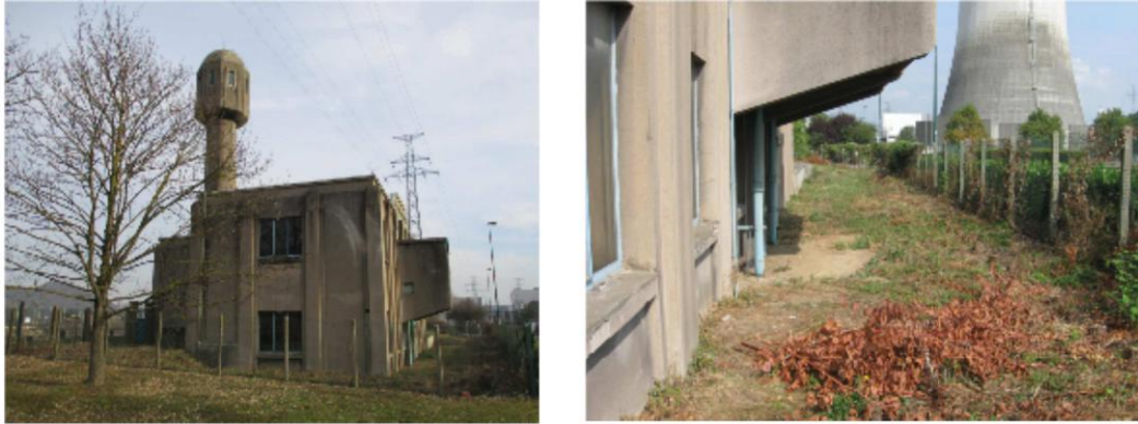
Fig.49 : Vues de la façade Ouest et de l'arrière de la parcelle
