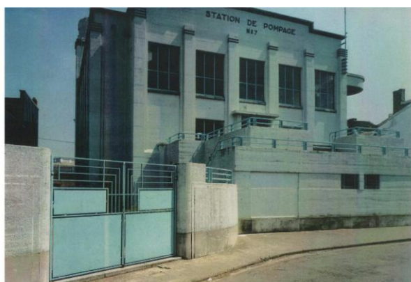
Fig.116 : Vue de la façade Nord
