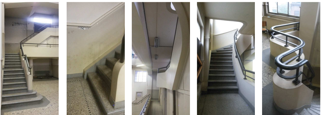
Fig.121 : Vues ascensionnelles de l'escalier en granito
