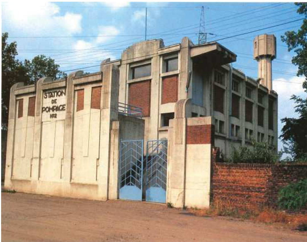
Fig.239 : Façade de la station de pompage Seraing n°2
