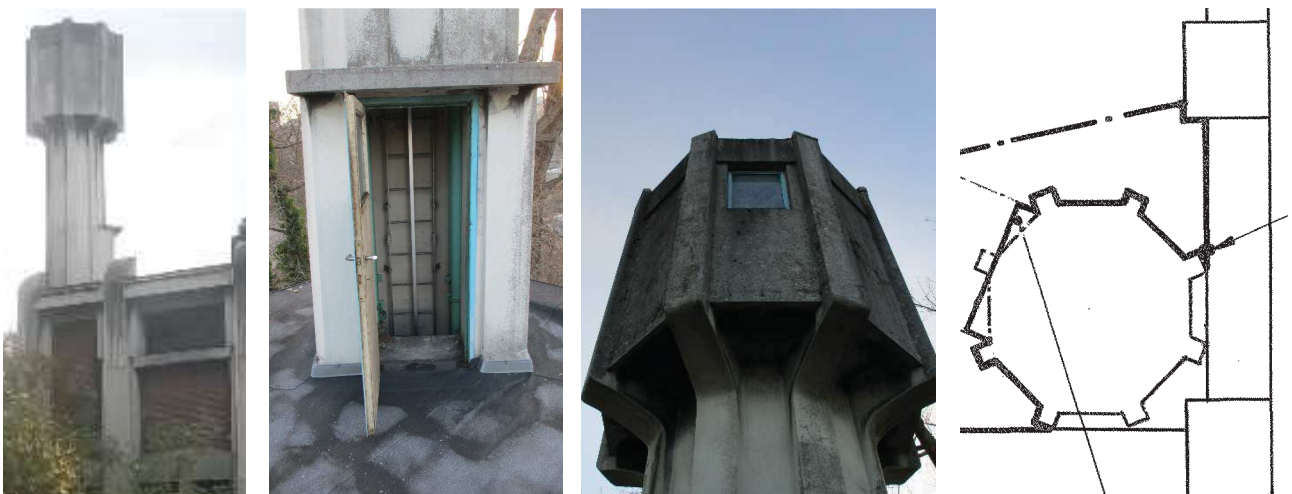
Fig.82 : Vues et plan de la tourelle d'amorçage
