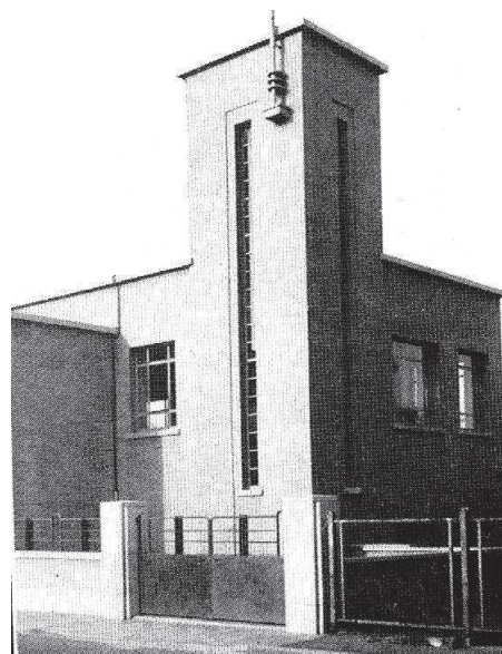
Fig.241 : Station de pompage Tilleur 12
