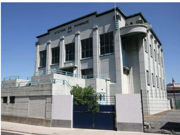
Fig.105 : Vue de la façade Nord
