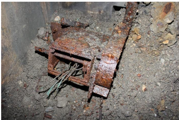
Moteur de commande d'un monte-charge. Fort de Fléron (photo personnelle).
