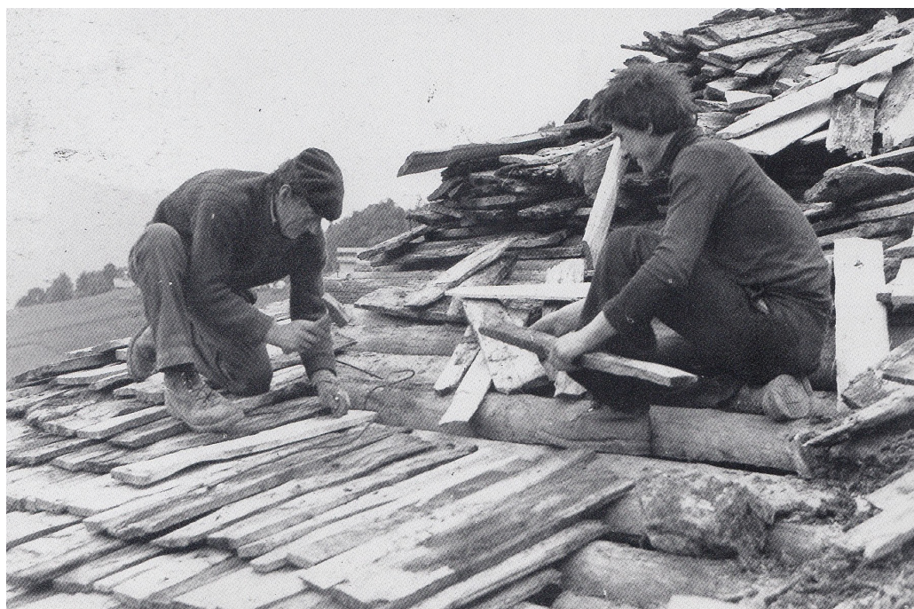
Ill 37. Pose des "ancelles"(bardeaux de bois non cloués) sur le toit d'une ferme.
