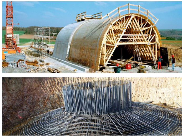
FIGURE 3.3 – Exemple de coffrages complexes pour la réalisation de pièces en béton armé [37] [41]
