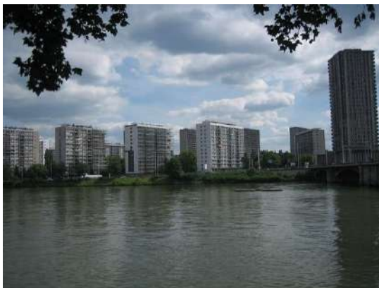
Figure 6: Les empilements de logements à Droixhe
